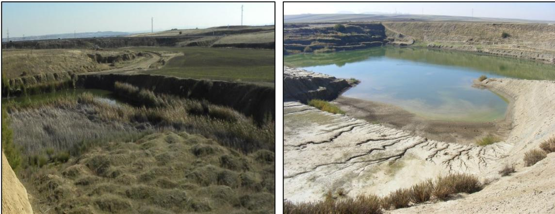
Figura 29. Izquierda: hueco inundado y parcialmente relleno con tierras de excavación de la cantera Valanzana. Derecha: Hueco inundado de la cantera La Paloma II
